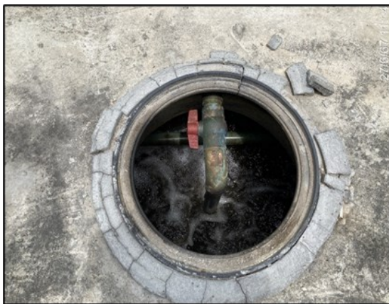
รูปที่ 2-31 : ระบบบำบัดน้ำเสียแบบเติมอากาศ บริเวณอาคารสำนักงานและบ้านพักคนงาน
