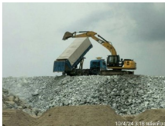
รูปที่ 2-8 : การปิดคลุมขณะเทกอง
