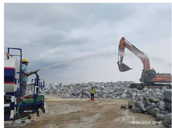
รูปที่ 2-9 : การฉีดพรมน้ำระหว่างเทกอง
