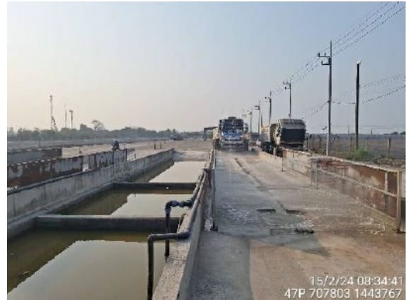
รูปที่ 2-17 : ล้างล้อก่อนออกจากพื้นที่โครงการ
