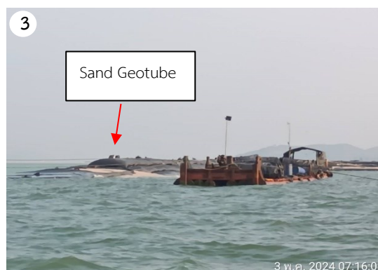
การก่อสร้าง Sand Geotube บริเวณท่าเรือชายฝั่ง
