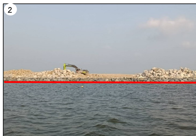
เขื่อนล้อมพื้นที่ถม (Revetment) ที่อยู่ระหว่างการก่อสร้าง
