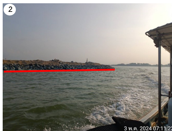
เขื่อนล้อมพื้นที่ถม (Revetment) ที่อยู่ระหว่างการก่อสร้าง
