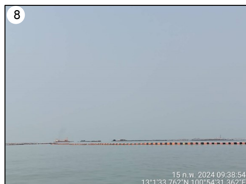
ม่านกันตะกอนบริเวณพื้นที่ก่อสร้างเชื่อมล้อมพื้นที่ถม
