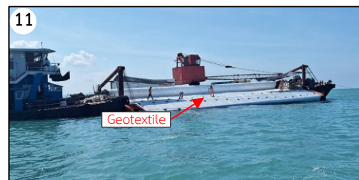
เรือปู Geotextile บริเวณบ่อทิ้งตะกอน
