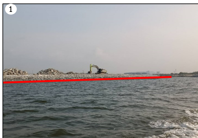
เขื่อนล้อมพื้นที่ถม (Revetment) บริเวณที่ก่อสร้างแล้วเสร็จ
