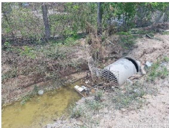
รูปที่ 2-71 : ตะแกรงดักขยะ
